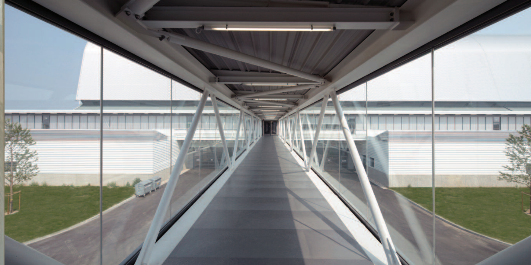
Project: Centre de Maintenance Cargolux, Luxembourg-Findel Architect: © Jean-Luc Dupanloup, chef de projets, Jean-François Schmit Architectes Photography: © Gaston Bergeret
